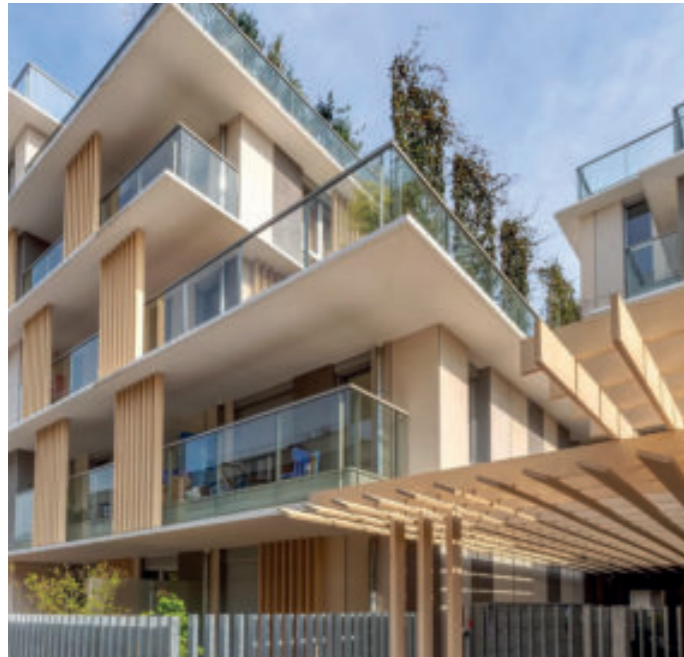
Accoya-Sonnenschutz beschichtet mit AQUAPRIMER und AQUATOP
